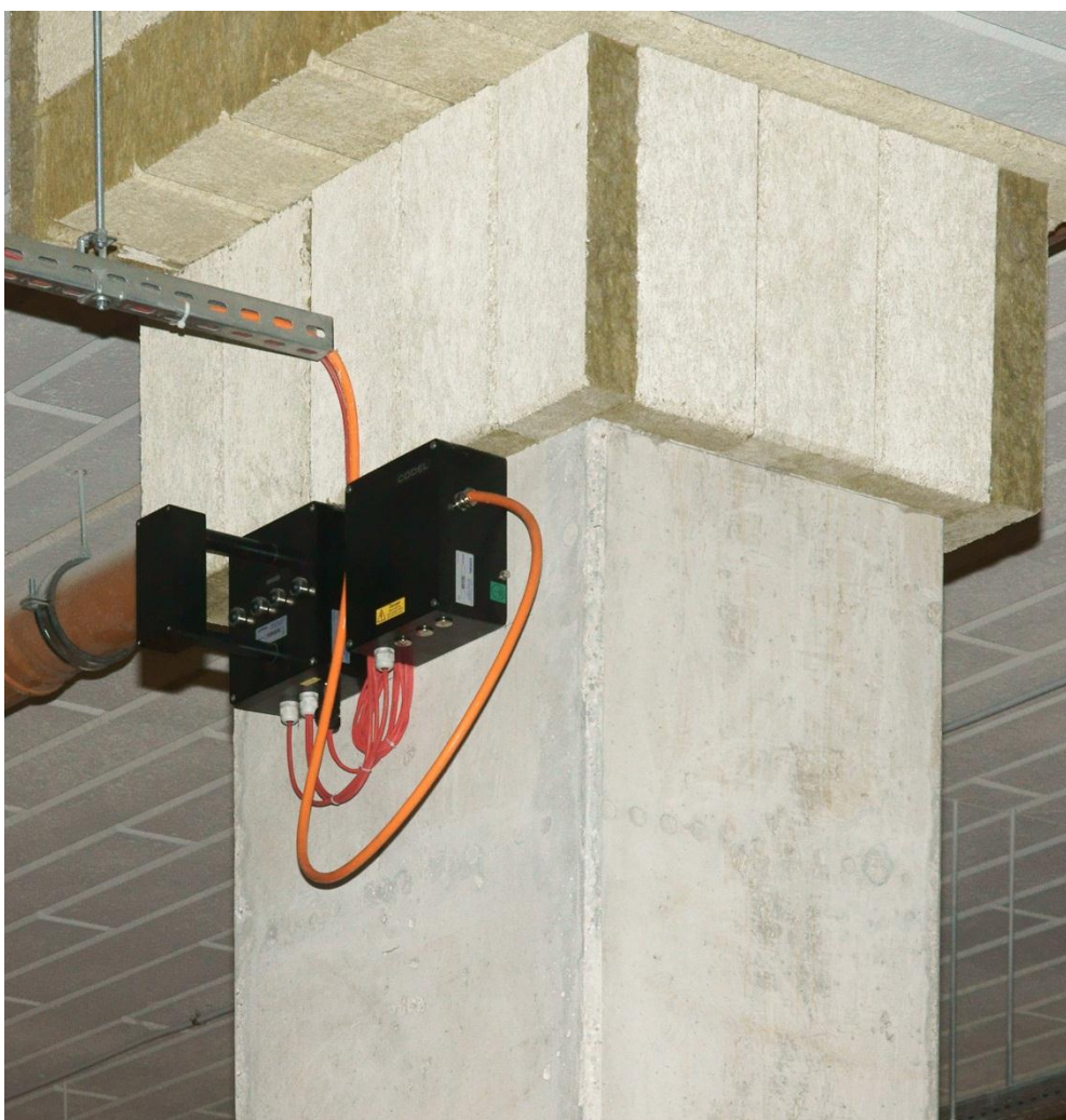
Rysunek 8 : Miernik kierunku i prędkości przepływu powietrza AFM
